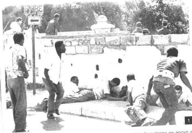
1. El pueblo rodeó la fortaleza armado con armas rudimentarias en apoyo a los contingentes que atacaban el cuartel general del temible cuerpo de Cascos Blancos. 2. Boquete Abierto a la ominosa fortaleza
